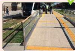
Rampa com piso tátil e guarda-corpo
