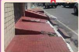
Calçada com rampa para automóveis
