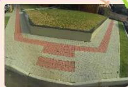
Desnível de calçada com piso tátil e rampa
